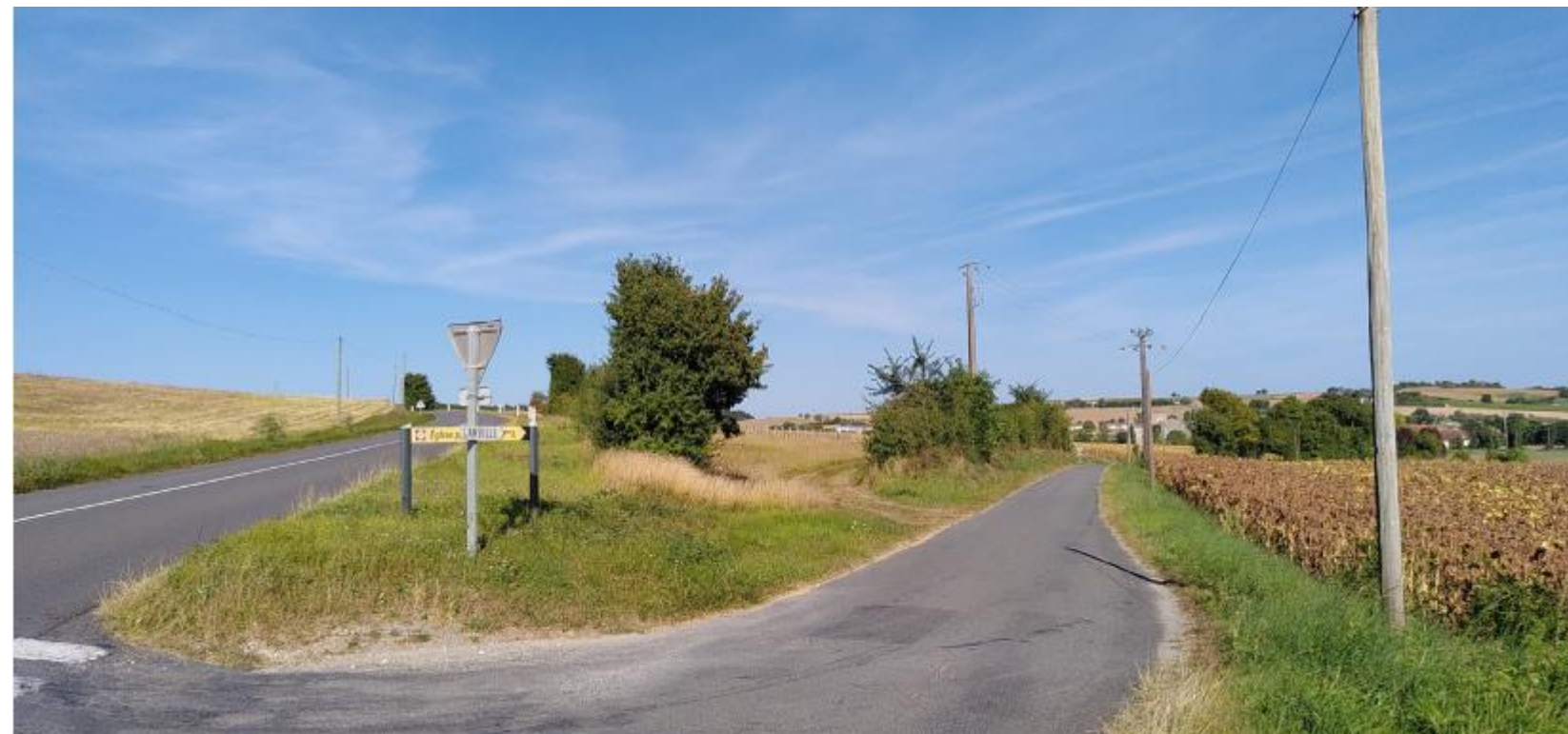
Figure 78 : Vue au niveau du carrefour de la Bretaudière (Source : Epycart)
