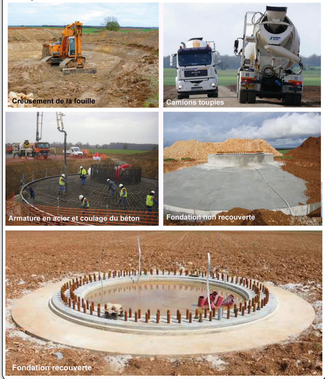
Photographie 46 : Étapes de réalisation d'une fondation d'éolienne
