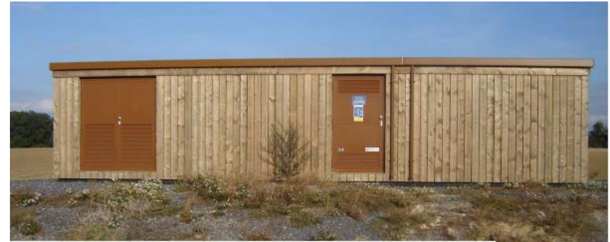
Photographie 55 : Exemple d'habillage du poste de livraison (Source : Epycart)
