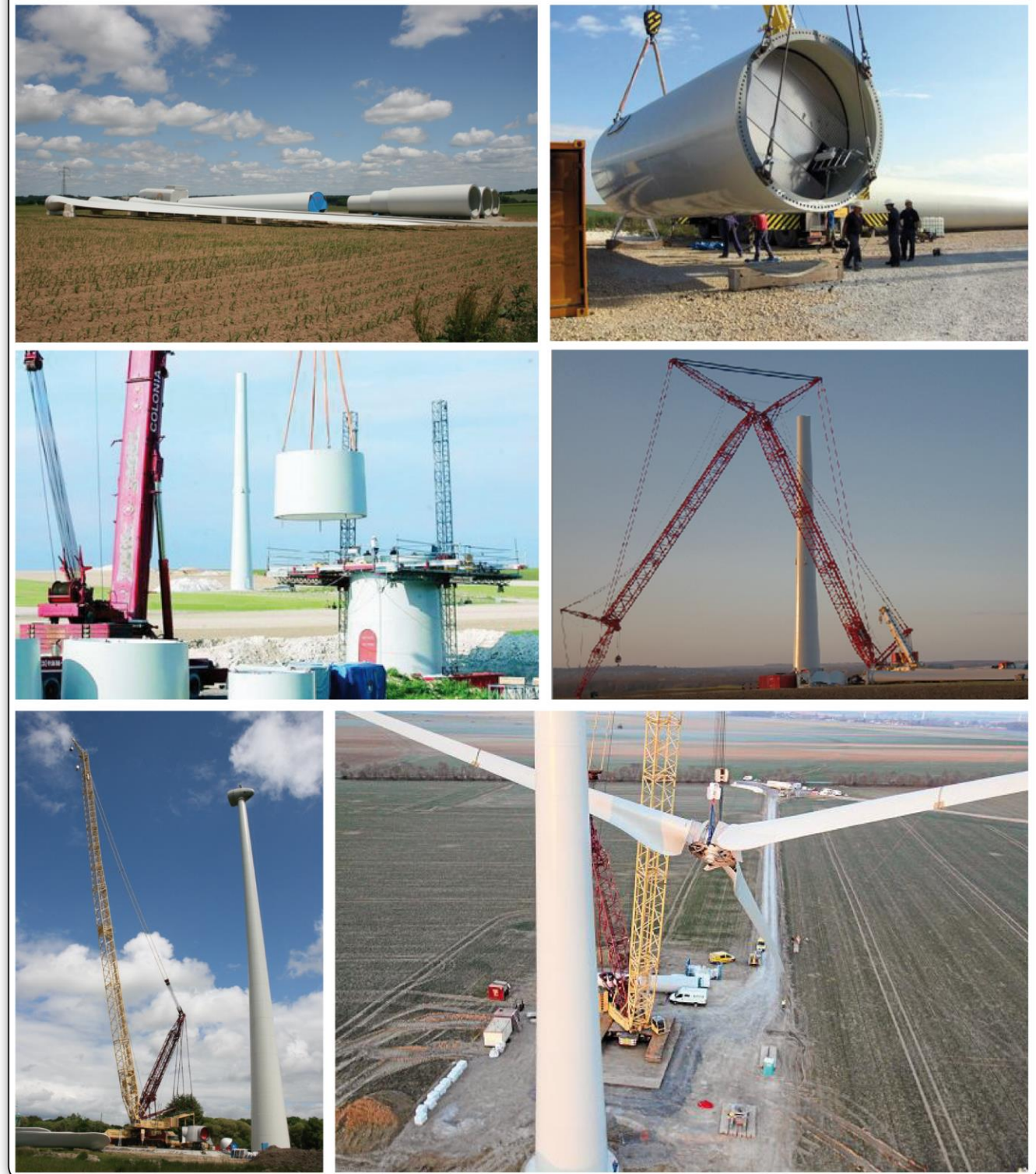
Montage d'une éolienne
