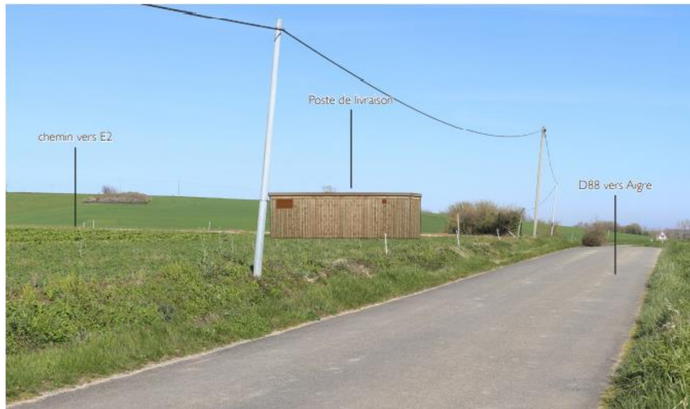
Photographie 54 : Intégration du poste de livraison le long du chemin menant à l'éolienne E2 (Source : Epycart)
