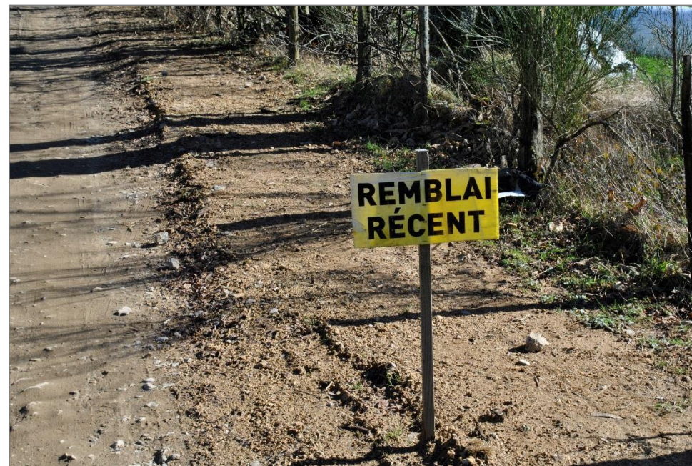
Photographie 50 : Exemple de remblai des tranchées électriques le long d'une piste (Source : ENCIS Environnement)
