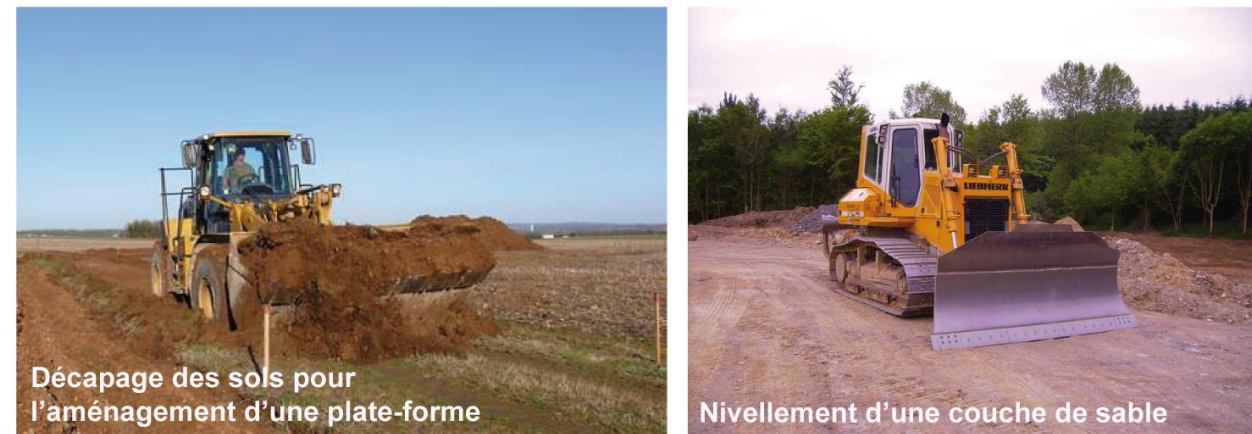
Photographie 45 : Exemples d'engins de travaux de VRD
